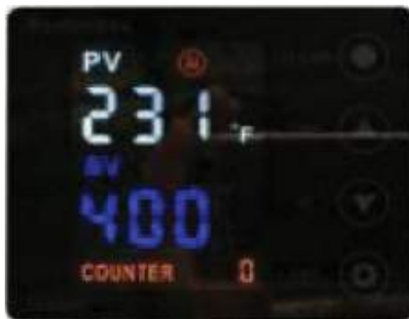
Finestra pannello di controllo
